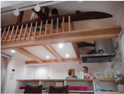
小屋裏をロフトとして生かした改修事例
